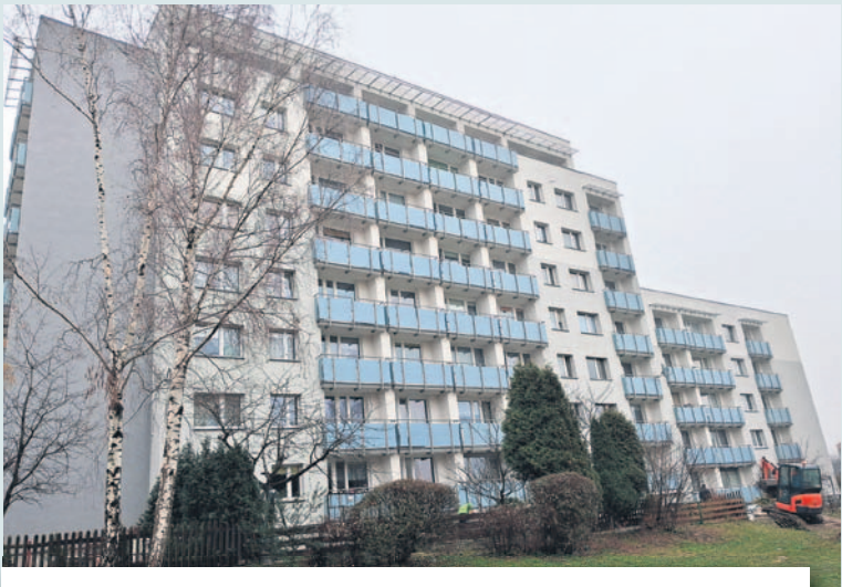
Zakończono realizację prac związanych z termoizolacją budynku oraz przebudową balustrad przy ul. Ustronnej 6-12 w Rejonie GZM nr 7. Zadanie zostało wykonane przez firmę zewnętrzną wyłonioną w postępowaniu przetargowym.
