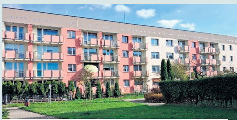
W Rejonie GZM nr 6 zakończono prace związane z dociepleniem elewacji zachodniej budynku przy ul. Wł. Reymonta 62-68. ▲ W ramach zadania wymieniono stare docieplenie na nowe, przebudowano balustrady w loggiach, wykonano izolację płyt loggii oraz położono nowe płytki. Dodatkowo zamontowano daszki na ostatnich kondygnacjach, a także wymieniono okienka piwniczne i naświetla. Zakończono również remont chodnika w podwórku, wzdłuż ul. Wł. Reymonta 28-36. ▼
